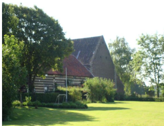
Monumentale hoeve (Bodemsweg)
